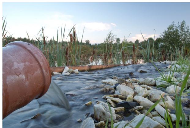
Figur 37. Grundvatten som tillförs en odling kan ha förhöjda koncentrationer av järn och mangan och vara syrefattigt, detta kan åtgärdas genom att vattnet först får passera en kalkbädd samtidigt som det luftas.
